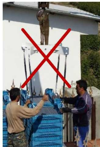
图7-1 用起重工具提升塔，吊绳环必须精确垂直
